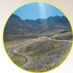
3) Construcción de carreteras
