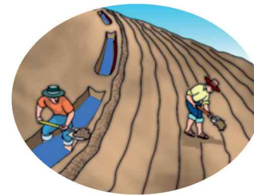
Figura 98. Realizando el mantenimiento de la zanja de infiltración.
