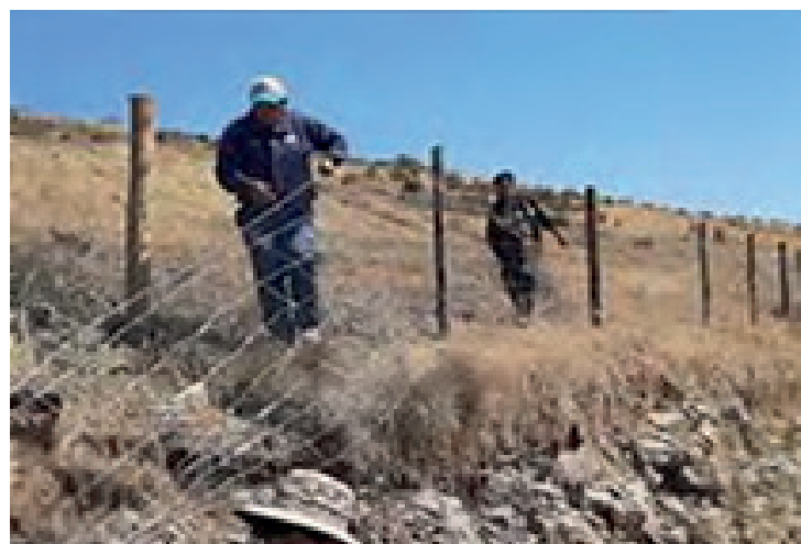
Figura 118. Construcción de cercos
