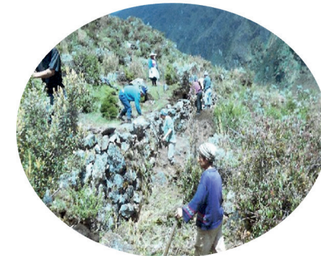
Figura 90. Reconstrucción de muro
