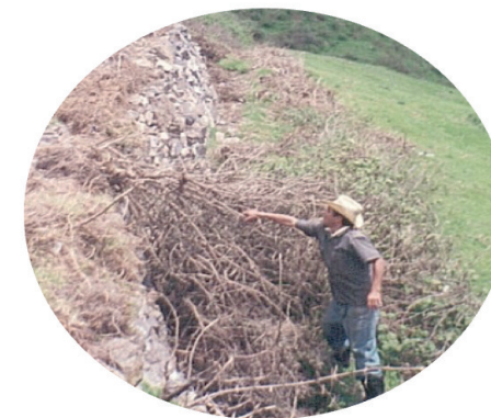
Figura 87. Limpieza del terreno
