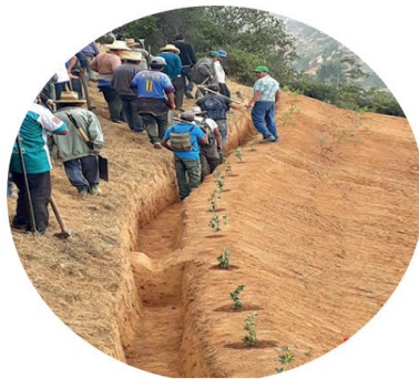
Figura 97. Zanjas de infiltración para la GRD
