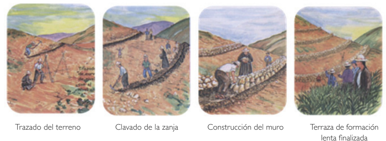
Figura 76. Construcción de terrazas de formación lenta
