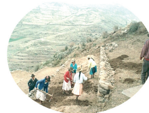
Figura 91. Nivelación de terraplén
