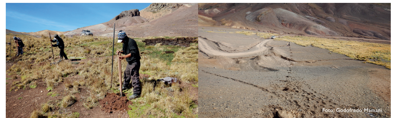
Figura 47. Colocación y apisonado de postes
