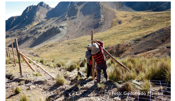
Figura 46. Tratamiento de postes con brea y plantado de postes esquineros
