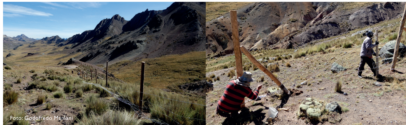
Figura 48. Cerco desplegado para colocación (izquierda) y tensión de malla ganadera (derecha)
