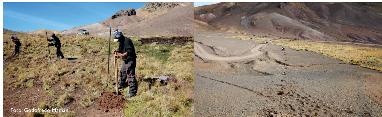
Figura 45. Apertura de hoyos para postes y hoyos concluidos
