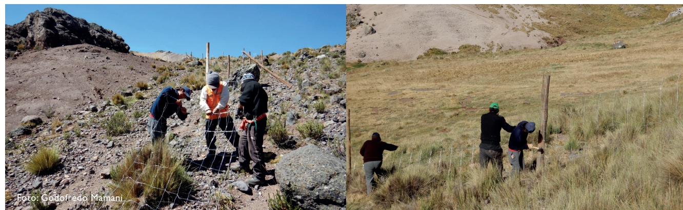
Figura 49. Unión de malla contigua (izquierda) y engrapado de malla al poste
