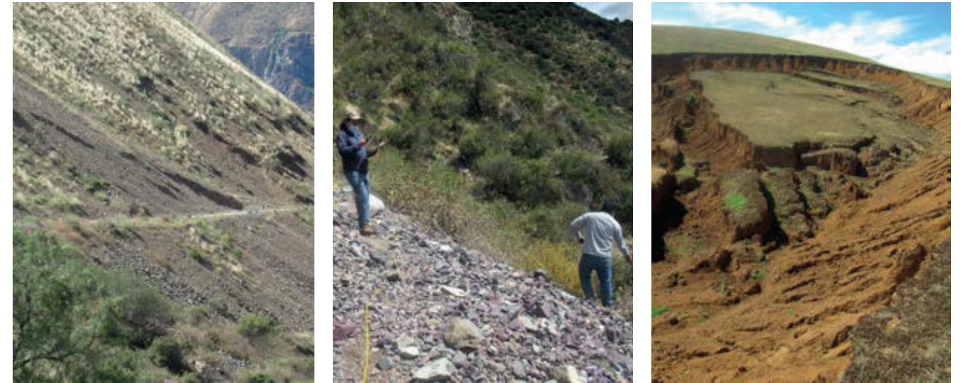
Fotografía 9. Presencia de Movimiento de masa (izquierda), piedras (centro) y suelos (derecha)
