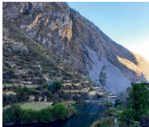
Figura 39. Fotografía ilustrativa de erosión laminar superficial en el distrito de Huancaya, cuenca Cañete
