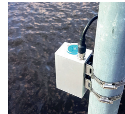
Figura 21. Estación de medición con equipamiento láser
