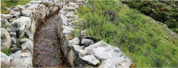
**Canales de infiltración:** canales de tierra y acequias que transportan el agua hacia las laderas de infiltración, permitiendo de manera simultánea la infiltración de agua hacia el subsuelo. Se han identificado hasta 30 canales de infiltración ancestrales en Huamantanga<sup>11</sup>, de los cuales 11 continúan en operación. Los restantes fueron abandonados o se encuentran obstruidos.
